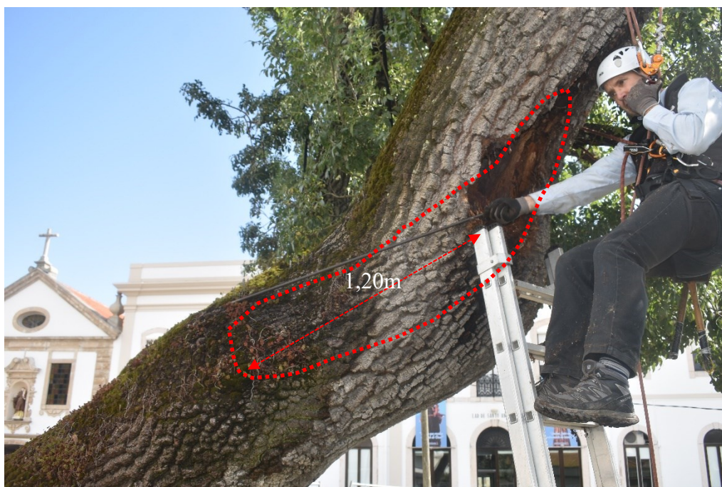
Figura 14 – Medição do comprimento do lenho degradado pela colocação no seu interior de vareta de aço.
