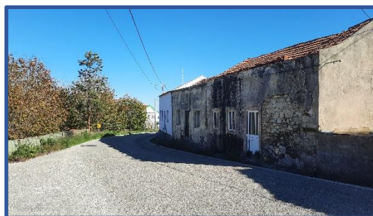
Figura 10: Rua da Figueira da Foz (Alhadas de Cima)
