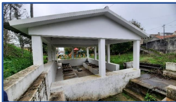
Figura 7: Lavadouro (Rua da Fonte Velha)
