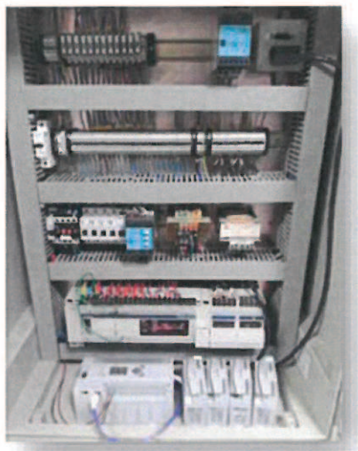
ETA de Vila Verde - Trabalhos de Substituição de autómatos dos filtros
