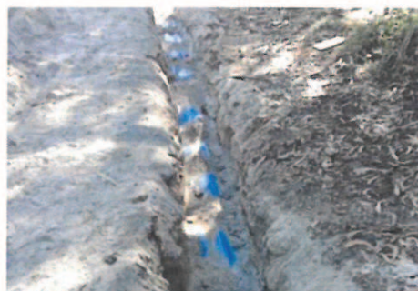
Instalação da conduta de abastecimento – Rua dos Almocreves
