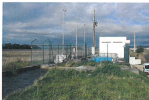
EE1 Vila Verde (Elevação para a ETA de Vila Verde)
