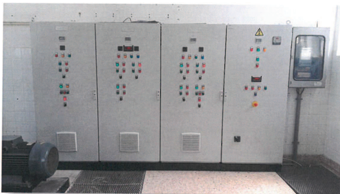
Fonte Quente - substituição do Quadro Geral de Baixa Tensão
