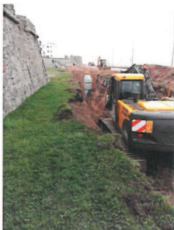
Tarmargueira – Instalação de Coletor
