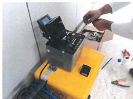
Trabalhos de Soldadura da Fibra Ótica
