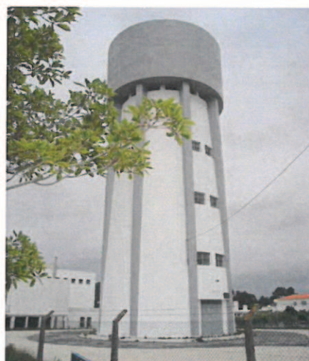
Reservatório Elevado (Paião)
