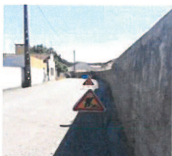
Sinalização dos Trabalhos – Ampliação de Conduta (Fonte Quente)
