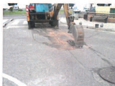
Abertura da Vala com Recurso a Retroescavadora (Buarcos)
