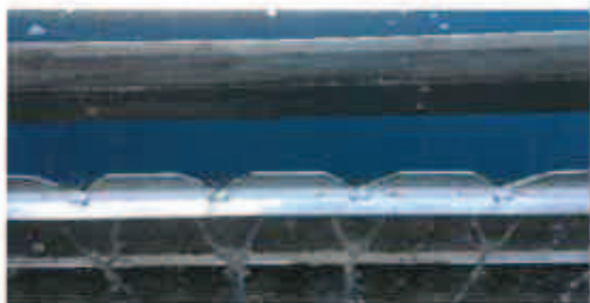
ETAR de S.to Amaro – Água tratada no decantador secundário após as intervenções
