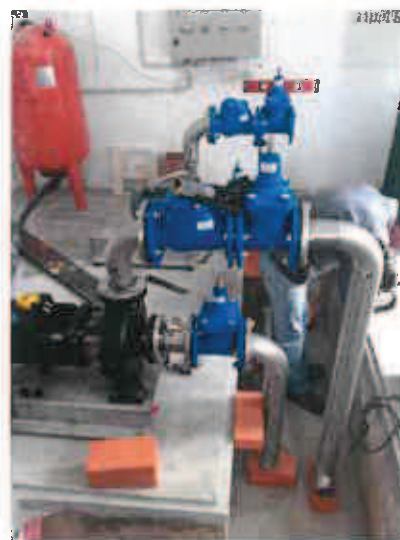
EE Abadias - Remodelação
