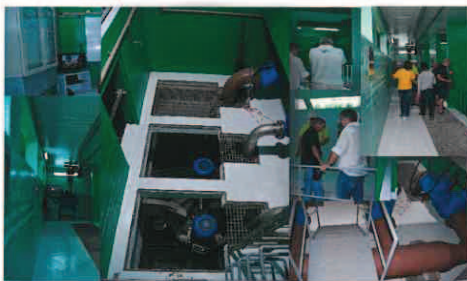
EE da Ponte Galante Renovada
