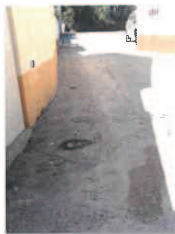
Rua António Pestana Rato, Buarcos/S. Julião (Conduite de abastecimento de água instalada)
