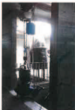
Remoção das bombas submersíveis
