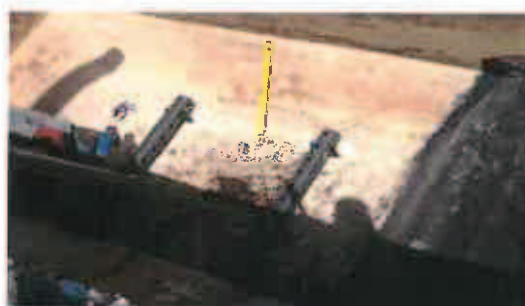
ETAR de S.to Amaro – Intervenções no decantador secundário
