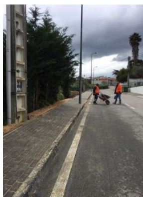
Execução de passeios, Maiorca
