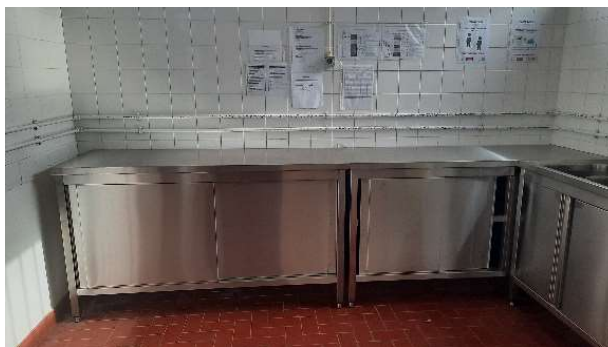
Remodelação do espaço de refeição da EB1 Regalheiras
