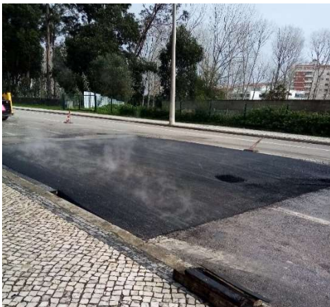
Execução de Passadeira
