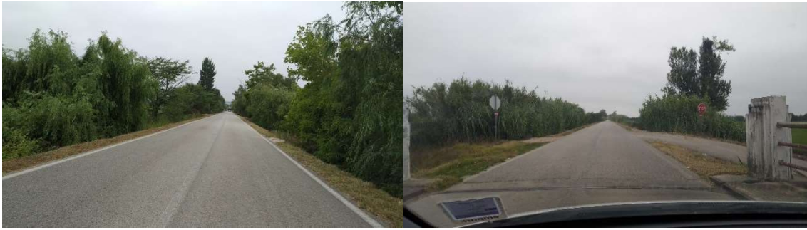
Bermas nas pontes de Maiorca (antiga EN 111)
