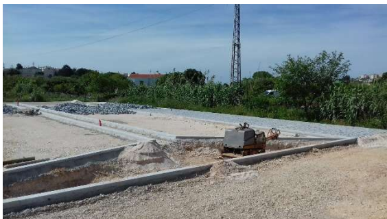
Aplicação dos cubos de granito
