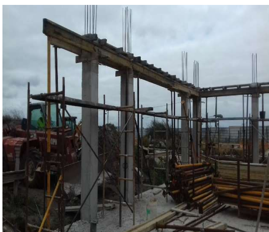
Foto 3 – Execução dos elementos estruturais do novo edifício exteriores
