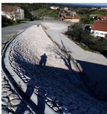
Execução do talude
