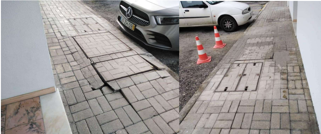
Correção de Pavê na Rua Agostinho Saboga, Tavarede (antes e depois)
