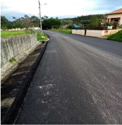
Execução de trabalhos de pavimentação
