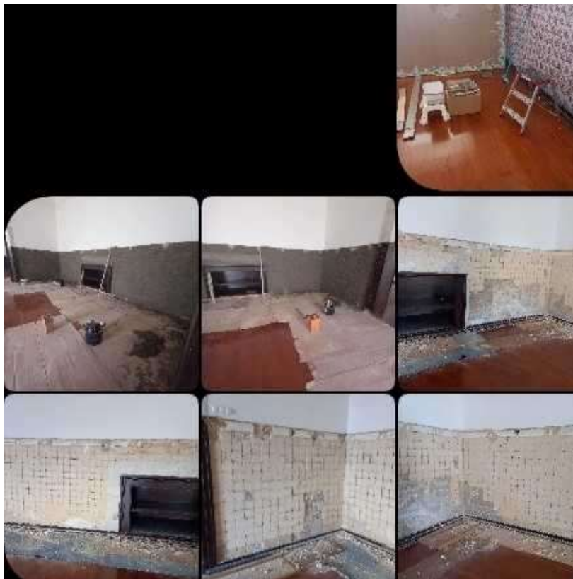
Preparação de paredes para receber azulejos reabilitados - Casa do Paço
