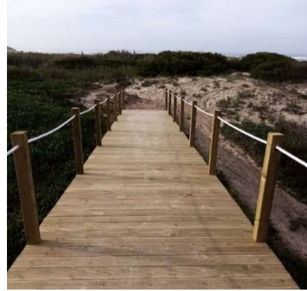
Execução de passadiço
