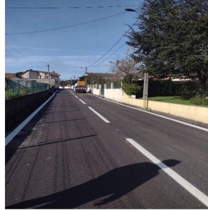
Execução de trabalhos de pavimentação
