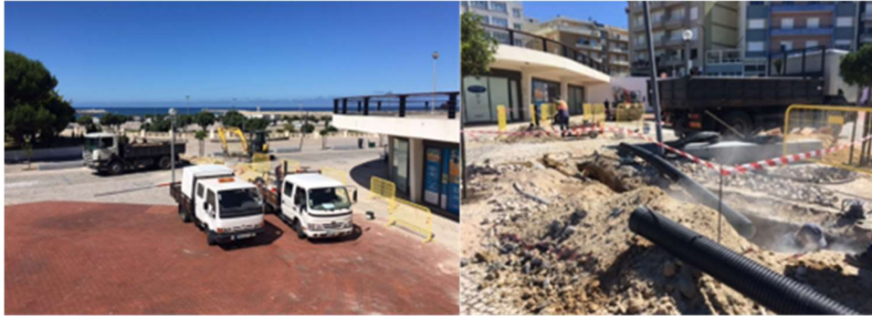
Ramal de saneamento doméstico, Praceta Ledesma Criado, equipa norte
