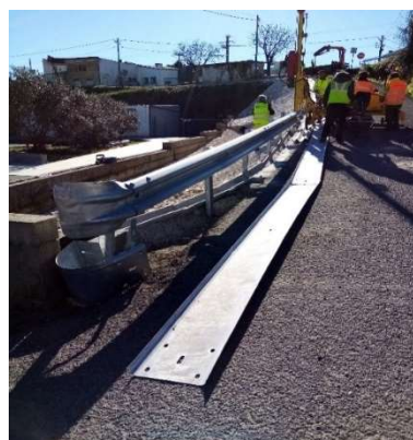
Colocação de guarda de protecção
