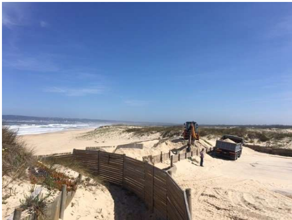
Remoção de areias junto às proteções, Costa de Lavos
