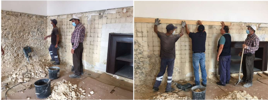
Preparação de paredes para receber azulejos reabilitados - Casa do Paço
