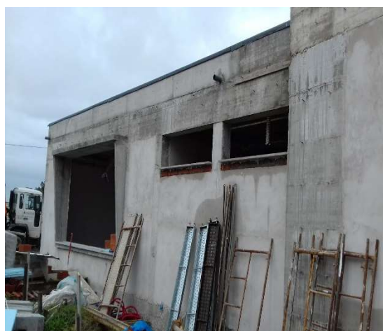
Foto 4 – Reboco das alvenarias
