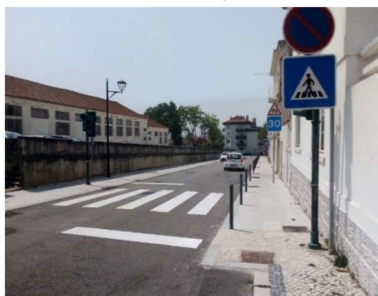
Pintura de passadeiras e colocação de sinalização, J. I. Conde Ferreira, São Julião
