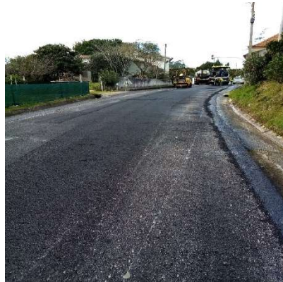
Execução de trabalhos de pavimentação
