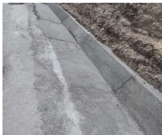
Execução de Muro
