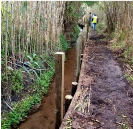
Execução de paliçada
