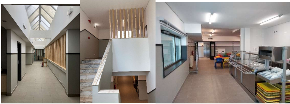
Fotos da obra em fase de conclusão
