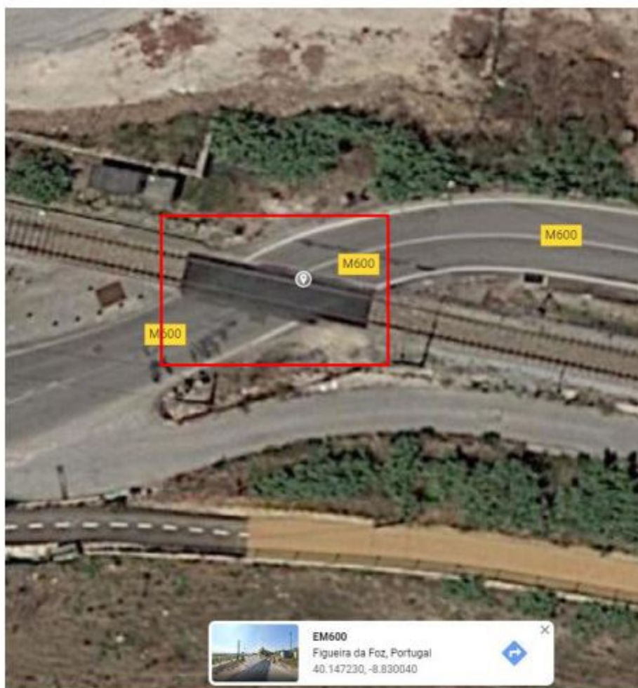
Representação do Local dos Trabalhos – Passagem de Nível Rodoviária PN 213+630
