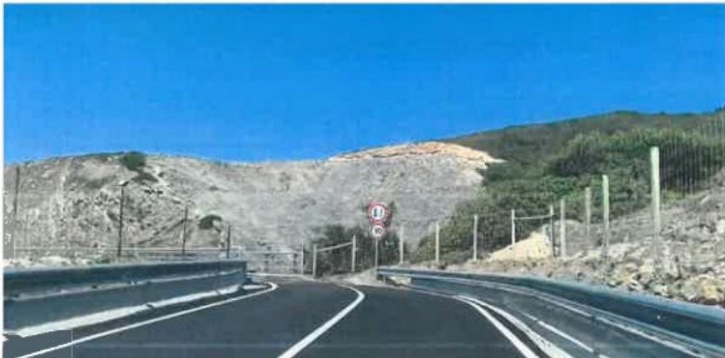
Fig. 1: Limite inicial da zona onde irão decorrer as obras de reparação das vedações à esquerda, através da estabilização de viatura no sentido Murtinheira-Figueira da Foz (contrário ao sentido da fotografia).
